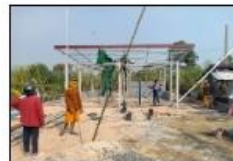
ขึ้นโครงหลังคาบริเวณระเบียงหน้าบ้าน พร้อมติดตั้ง..
