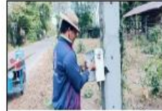
ดำเนินการซ่อมท่อน้ำแตกบ้านโนนเหลื่อม หมู่6 , ตรวจ..
